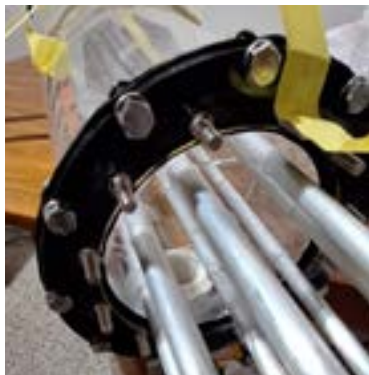
FIGURA 17 — Encaixe da nova flange e anel de vedação no trocador de calor
