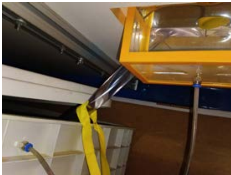
FIGURA 24 — Ponto de saída da água do casco trocador de calor
