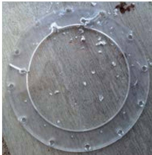
FIGURA 18 — Falha na tentativa de adaptação da flange exterior
