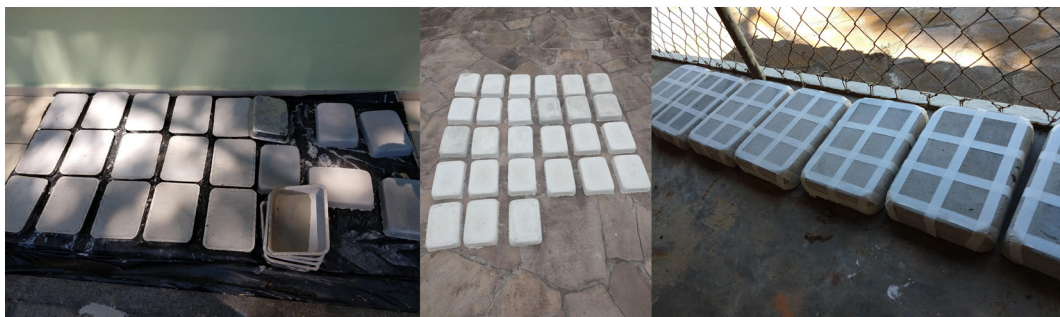
FIGURA 2 – Preparação dos moldes de argamassa
