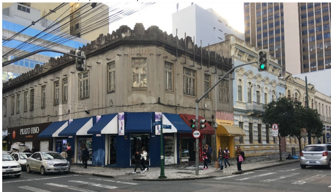
FIGURA 03 – Verifica-se que o imóvel situado na Rua Barão do Rio Branco é ocupado somente no térreo; o pavimento superior encontra-se sem uso.
